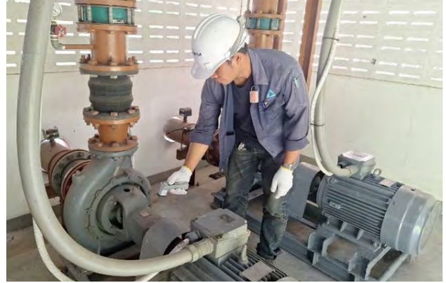
ตรวจวัดค่าความร้อนของมอเตอร์/ปั๊ม
