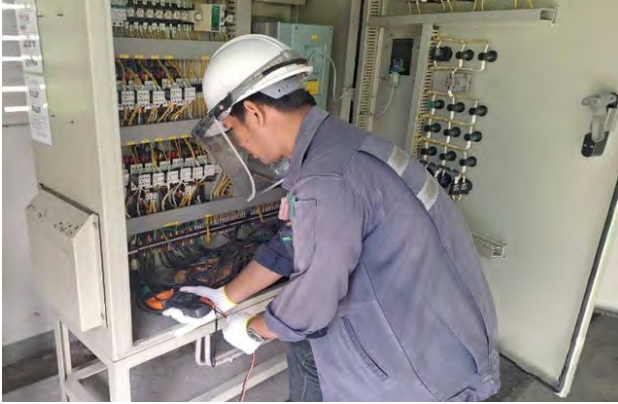
ตรวจเช็คกระแส/แรงดัน
