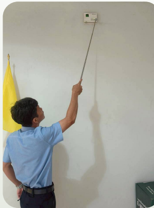
เลื่อนเวลาเปิด-ปิด เครื่องปรับอากาศภายในอาคารอมตะเซอร์วิสเซ็นเตอร์ลดลง 1 ชั่วโมง จาก 7:30-15:30 น.
