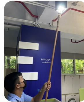
เปลี่ยนหลอดไฟเป็น LED ที่มีประสิทธิภาพสูง
