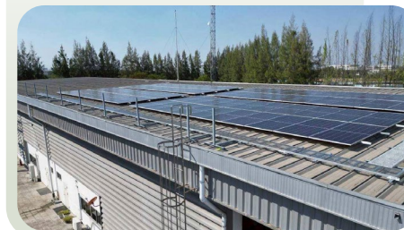
ติดตั้งระบบผลิตไฟฟ้าจากแสงอาทิตย์บนหลังคา (Solar Rooftop) อาคารคัดแยกขยะ ขนาด 52 กิโลวัตต์พีค (kWp)
