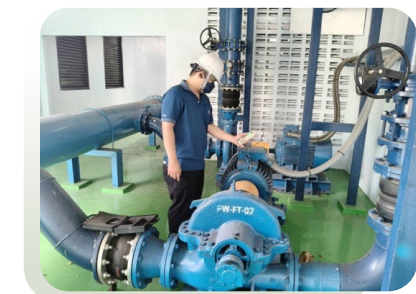
ตรวจวัดค่าความร้อนของมอเตอร์/ปั๊ม
